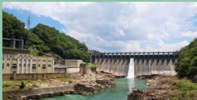
大井発電所、大井ダム
