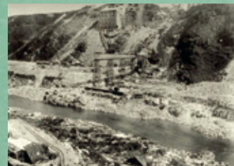
建設中の洪水
