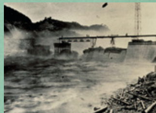
建設初期のダム
