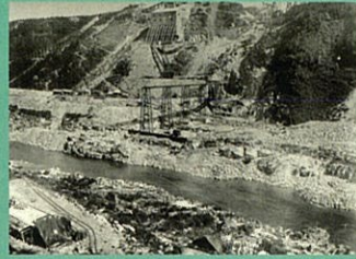
建設中の洪水
