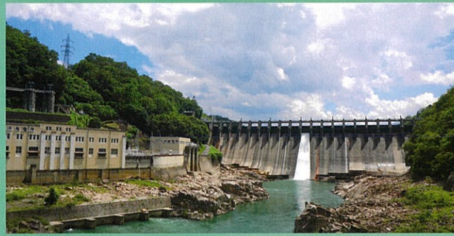
大井発電所、大井ダム
