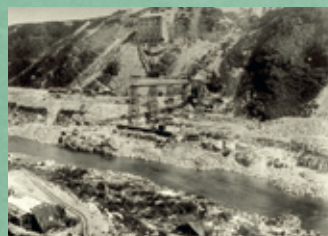
建設中の洪水
