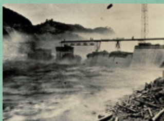
建設初期のダム
