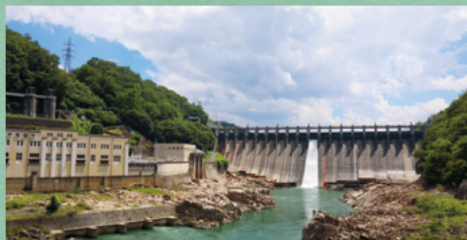
大井発電所、大井ダム
