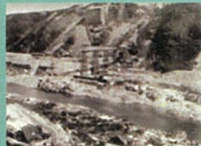
建設中の洪水
