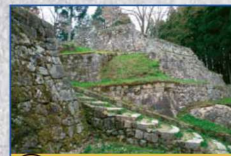
11 六段壁 CG 六段の石垣は、江戸時代後期に、崩落を防ぐ補強のために下段に石垣を継ぎ足した結果、現在の姿になりました。
