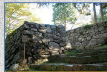
14 埋門 CG 野面積み・打込ハギ・切込ハギといった3種類の積み方が一度に見られる日本でも珍しい場所です。
